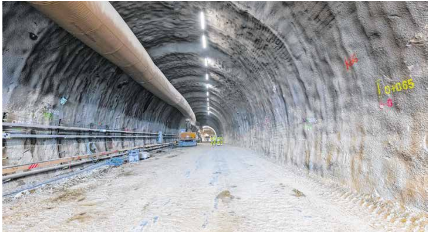
170 méter hosszan termelték ki a kőzetet, és építették meg az út felett vezető tartószerkezetet a Bécsi-domb alatt. FOTÓ: ROSTÁS JÁNOS
