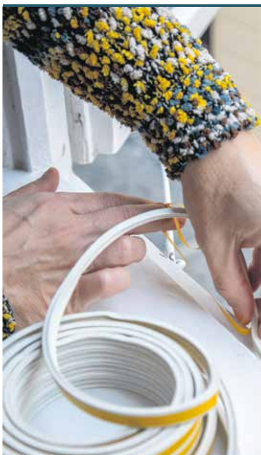
Az ablakra tehető szigetelőcsíkok öntapadók, így könnyű felragasztani azokat. Akár 1-5 milliméteres réseket is képesek megszüntetni.
